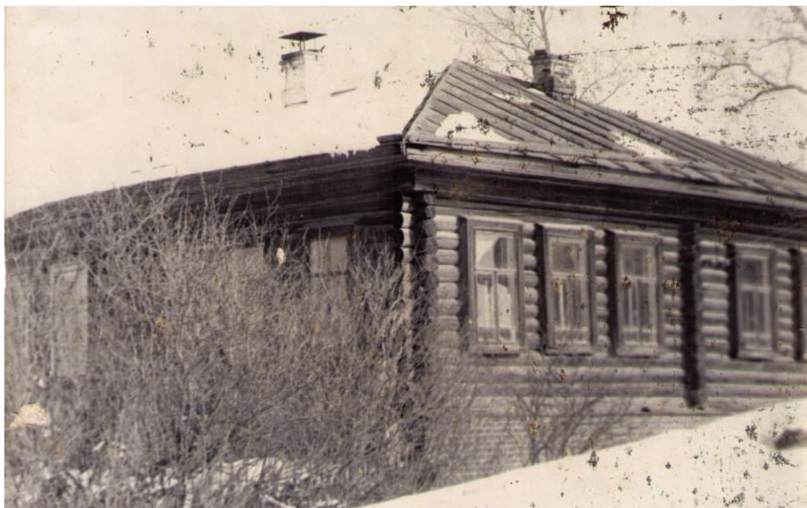
Здание Кругловской церковно-приходской школы
